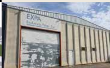
PALAU-SOLITÀ I PLEGAMANS Nau en lloguer, de 700m 2 (35x20) 8m d'alçada, oficines i vestuaris de 50m 2 , parets Hormipresa, sostre sandwich, ignífuga, 2 patis de 100m 2 , NO TÉ INSTAL·LACIONS. Preu: 2.300,00€/m 2
